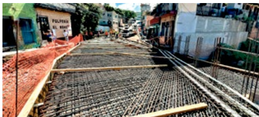
En la zona de "Los Jucos", del barrio Morazán, el megaproyecto de mitigación ha disminuido el riesgo de inundaciones que durante años afectaron a cientos de personas.
